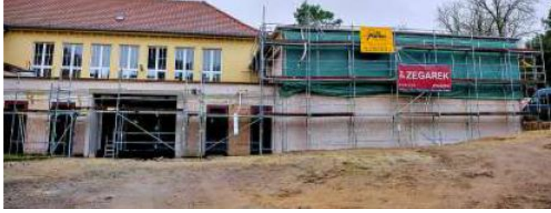
Die Baustelle im Reinsdorfer Schulkomplex
